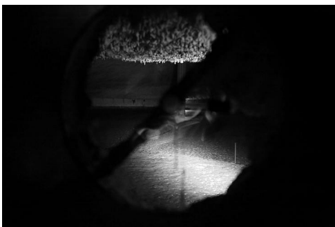
A l'intérieur d'un méthaniseur. Des déchets végétaux et animaux sont chauffés entre 35 et 40 degrés, pendant de longues heures. Photographie de ©Patrick Bard
